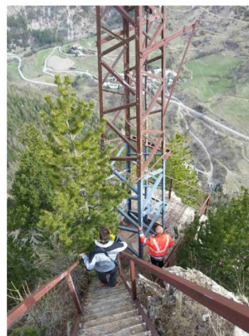
Nouvel équipement sur la ligne de Meyrannes
