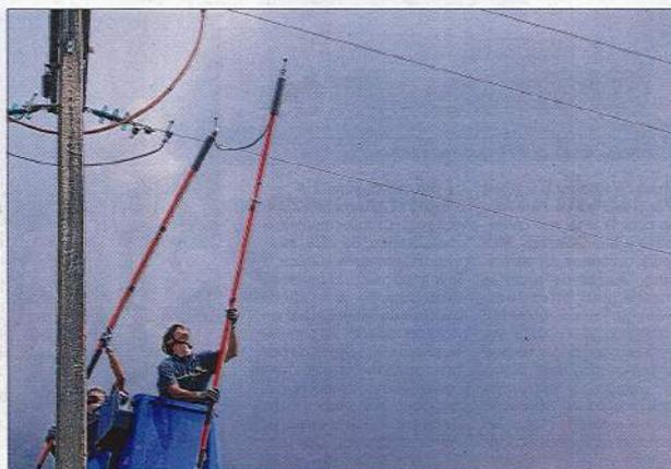
Pour protéger l'avifaune, et notamment les rapaces, des équipements spéciaux sont mis en place sur le réseau électrique. Photo Le DUM.P.
